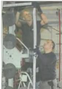
Kali Kamiran (rechts) baut gemeinsam mit Vorarbeiter Stephan Kelle die Scheibe in den Fensterrahmen.
